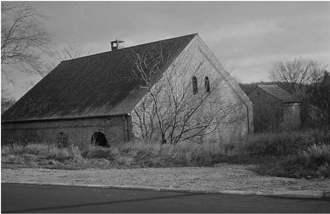
Pumpestation ved Hasselø
