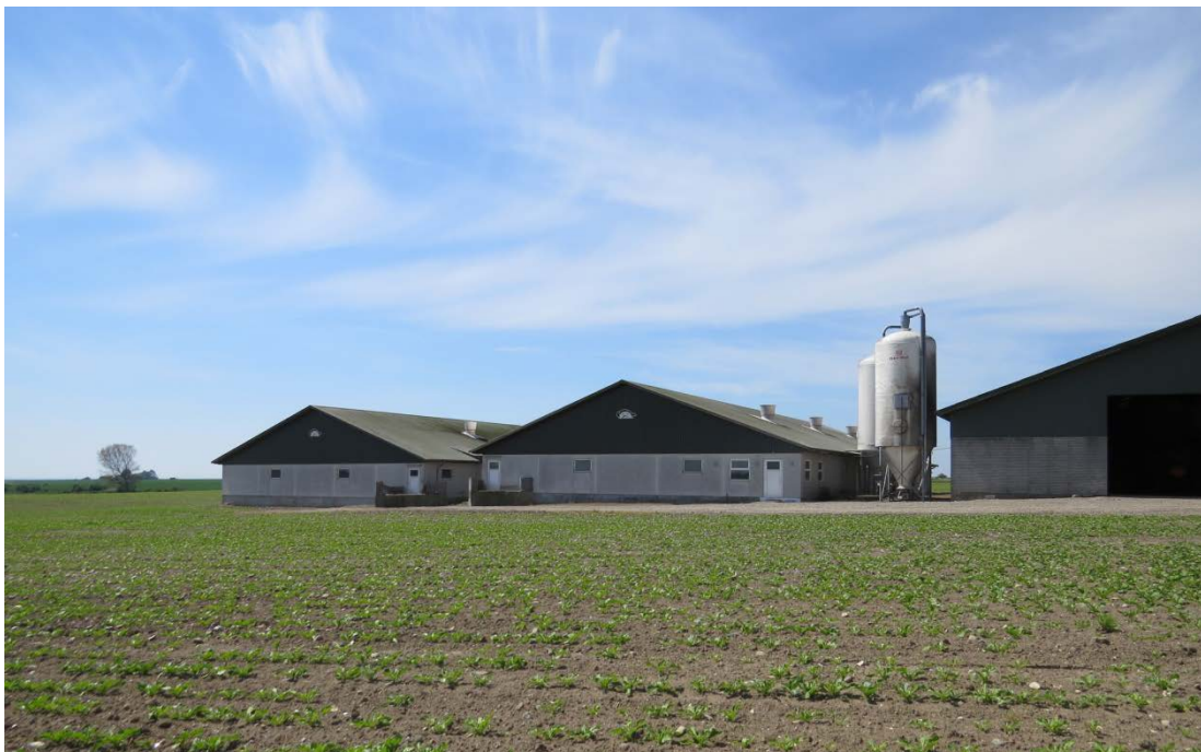
Driftsbygninger på Høeghsgård
