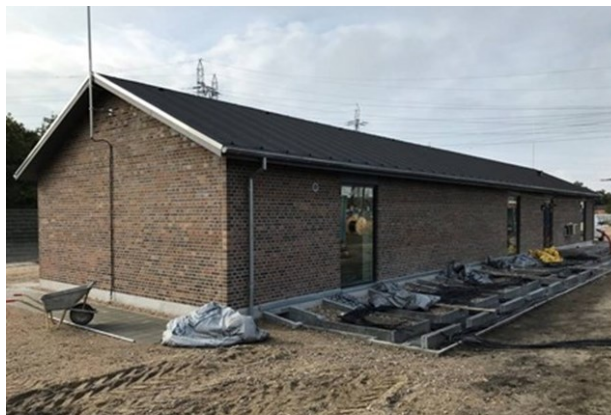
Figur 4. Eksempel på teknik- og mandskabsbygning.
