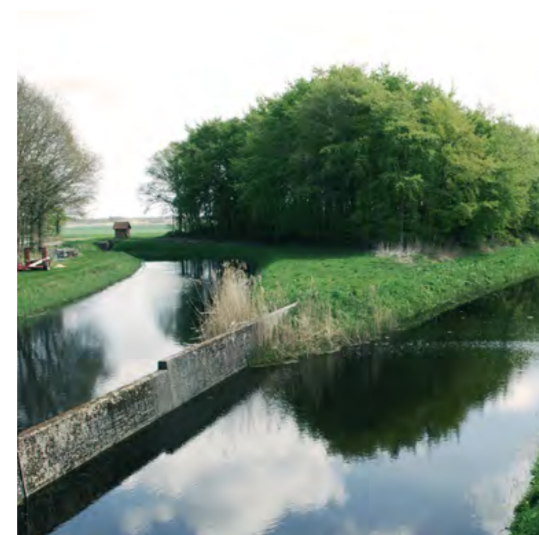
Foto fra Pumpestationen
