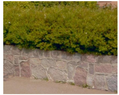
Eksempel stensætning med beplantning over.
