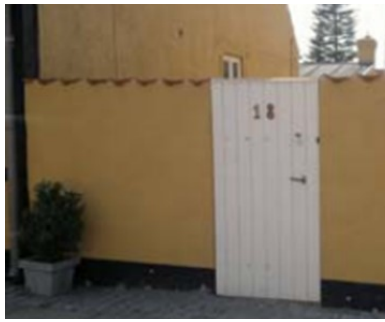
Eksempel på murværk i forlængelse af facade der står i skel mod vej.
