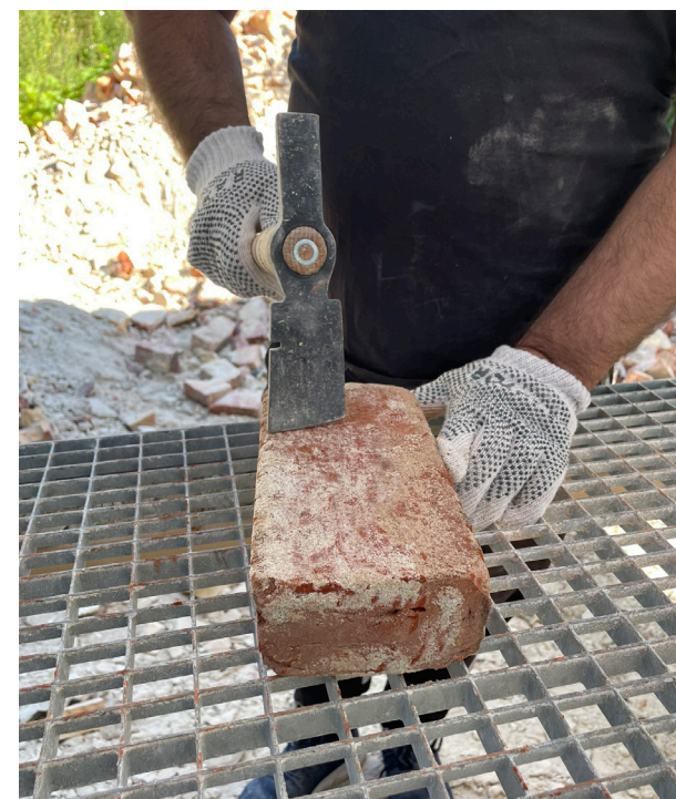
GENBRUG. MURESTEN KAN NEMT GENBRUGES NÅR DE ER BLEVET RENSET.
