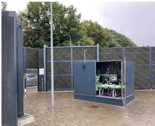
Figur 10 – Foto som viser eksempel på injektionsstation (midt i foto)
