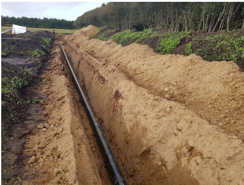
Figur 6 - viser ledningsgrav anlagt med begrænset arbejdsareal
