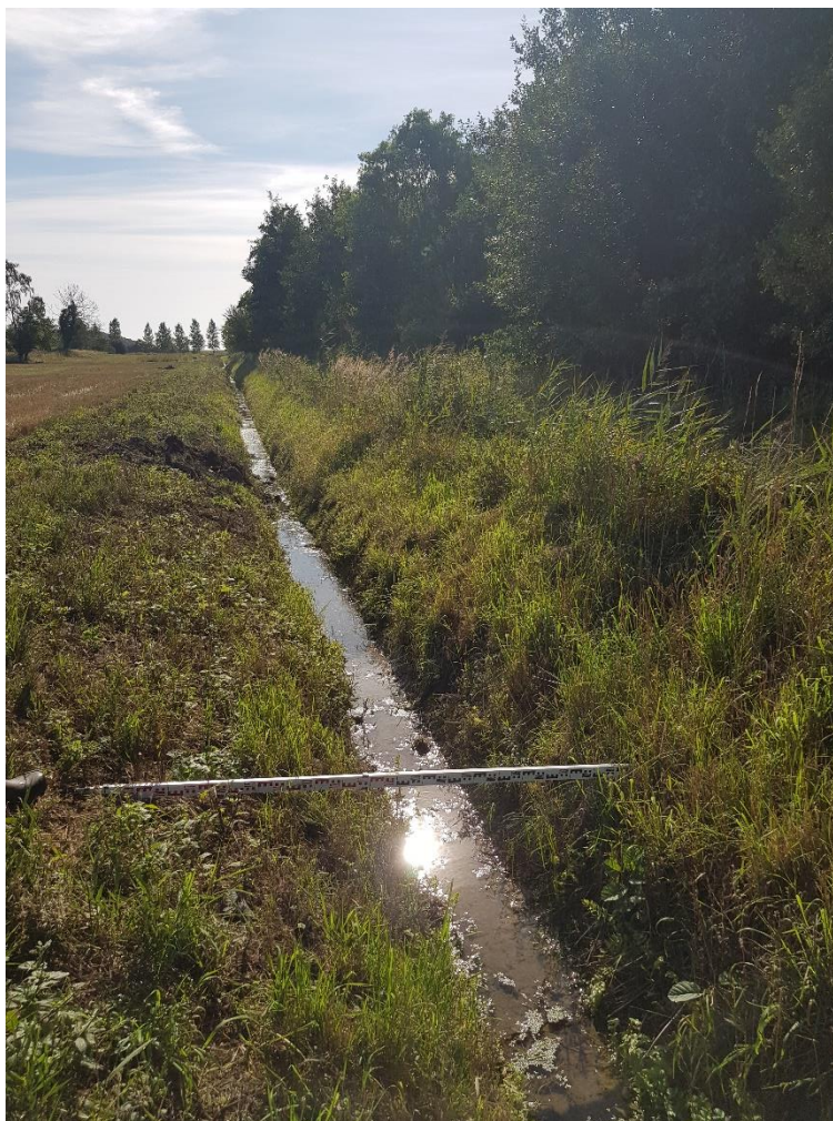
Billede 3: Eksisterende afvandingsgrøft set fra vest mod øst. Afvandingsgrøften er beliggende i den sydlige ende af projektområdet, og er den grøft, som vandløbet er tilsluttet.
